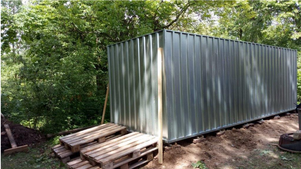
Abbildung 20 Unser neuer Abstellraum im Entstehen
