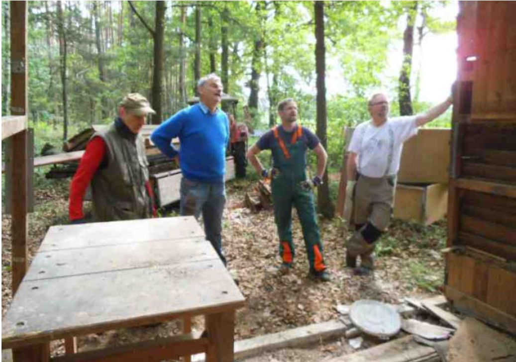
Abbildung 13 Das spätere Zeidlerhaus wurde am 12.6.2015 in Tuchenbach zerlegt und nach Herzogenaurach verbracht.
